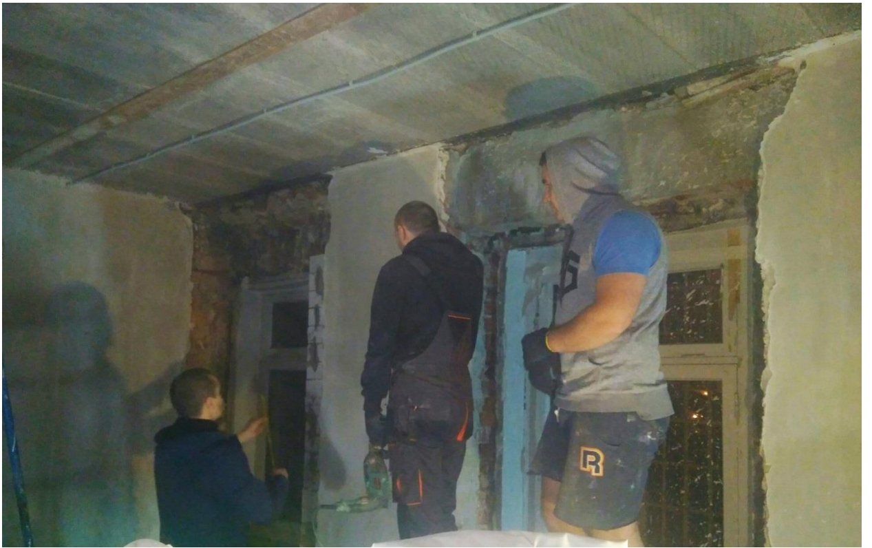
Работы по выравниванию стен, восстановлению оконных проемов.
