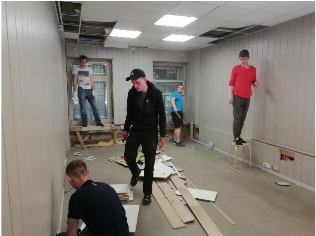
Демонтаж каркасных конструкций облицовки стен здания Семейного центра «Созвездие», июль 2018 г.
