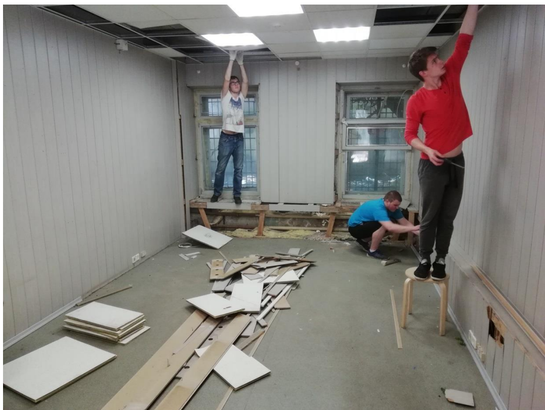
Демонтаж навесных потолков и демонтаж пола с целью дальнейшего ремонта жилых помещений здания.
